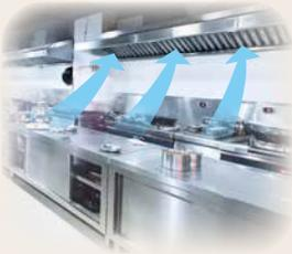
2. 在厨房适当位置加设局部排气装备，将热空气及蒸气抽到室外，可降低厨房内的温度及湿度，有助预防雇员患上热疾病。
