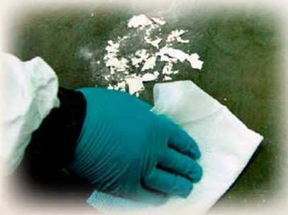
2. 在建築及拆卸工程中，適當採用濕抹法抑制石棉塵埃產生，以預防僱員患上石棉沉着病及間皮瘤。
